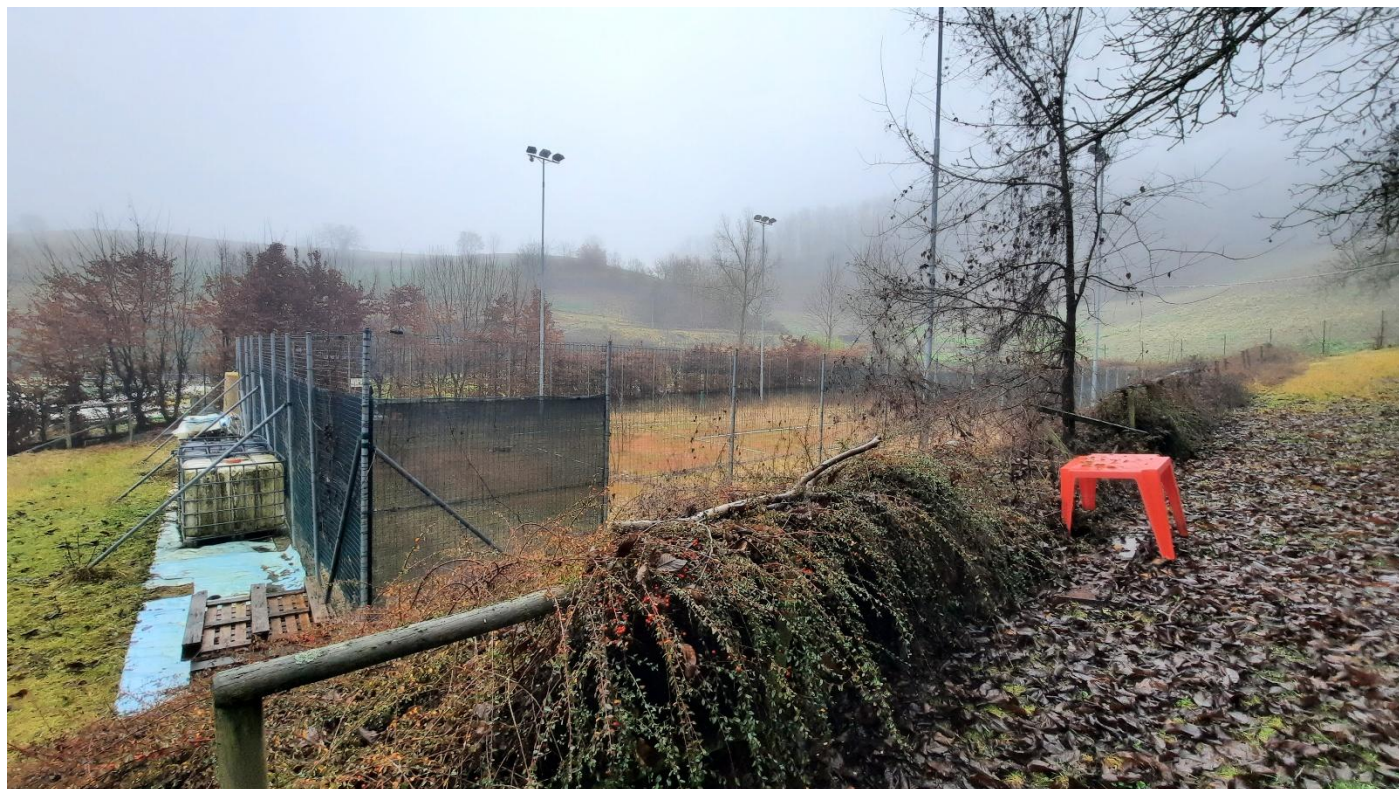
Foto 23 – Campo tennis in terra rossa da recuperare
