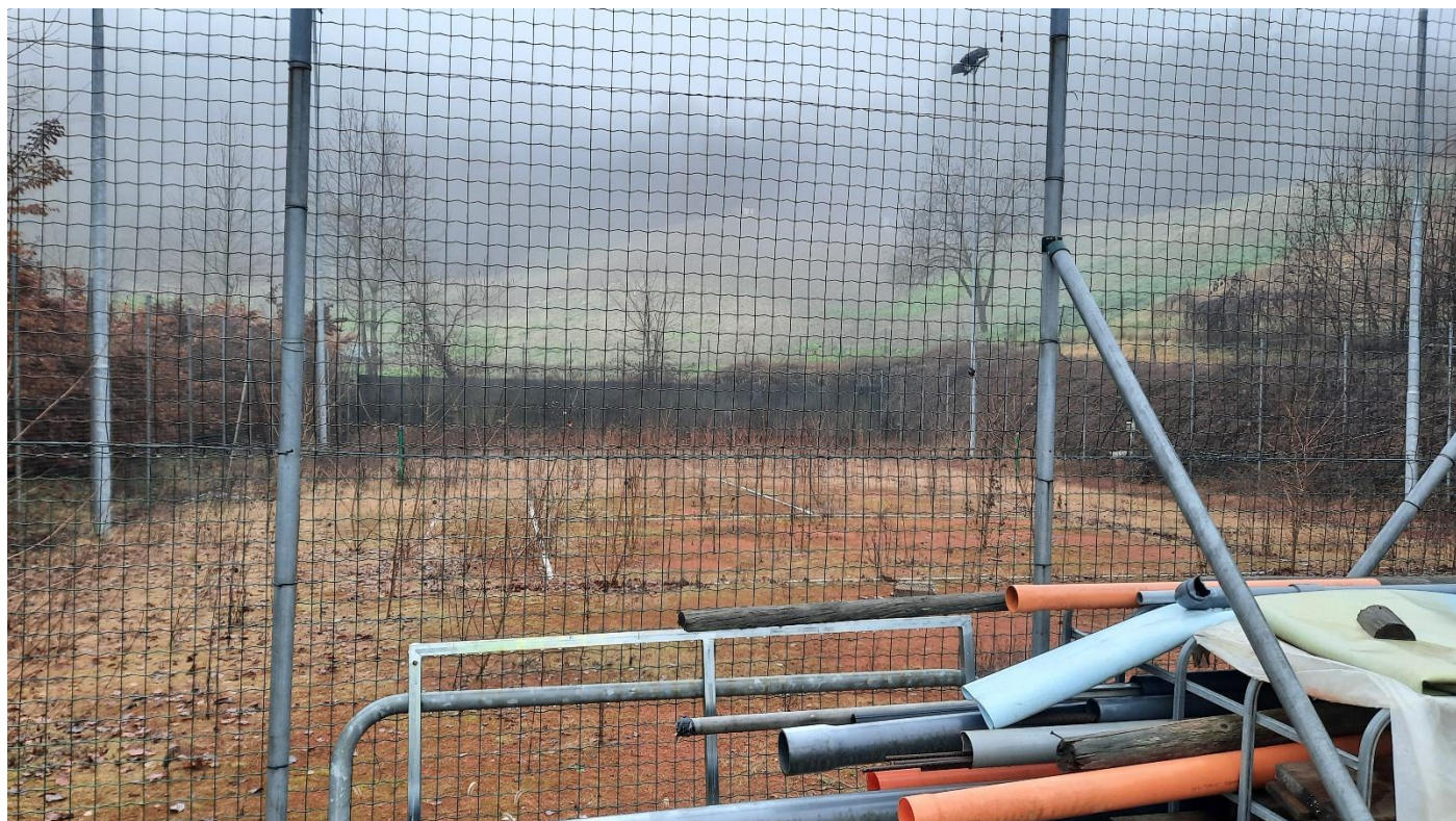
Foto 22 – Campo tennis in terra rossa da recuperare
